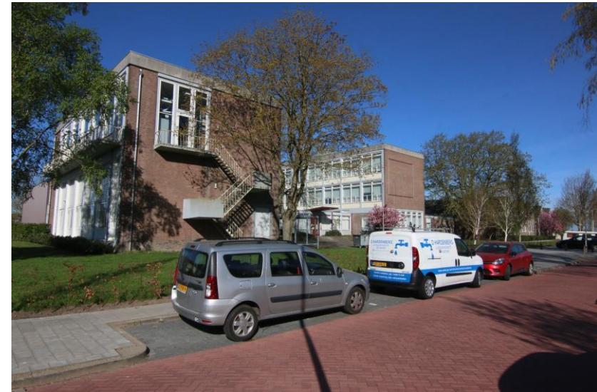
Overzicht LTS Schoonhoven
