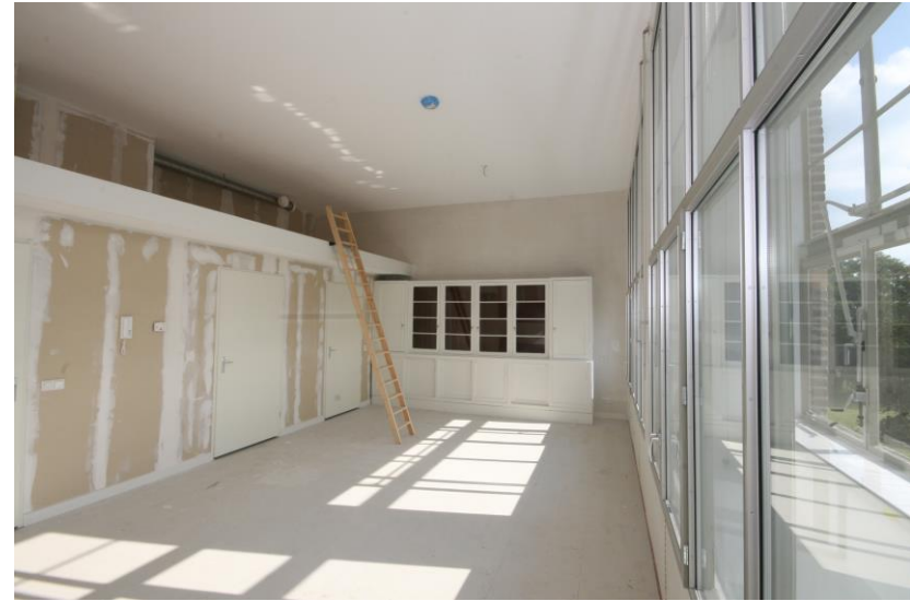
Overzicht 2 raams breed appartement in de Ambachtsschool met links de inbouw
