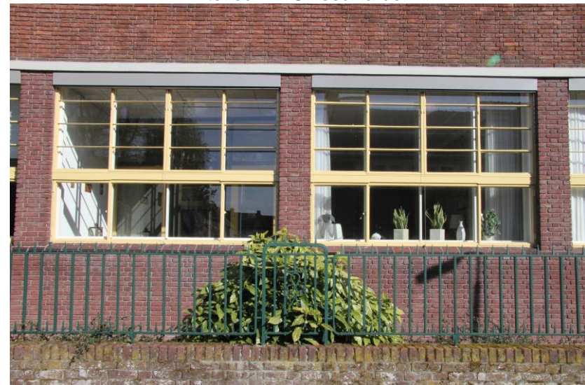
Exterieur 2 raams woning met links het inpandig balkon
