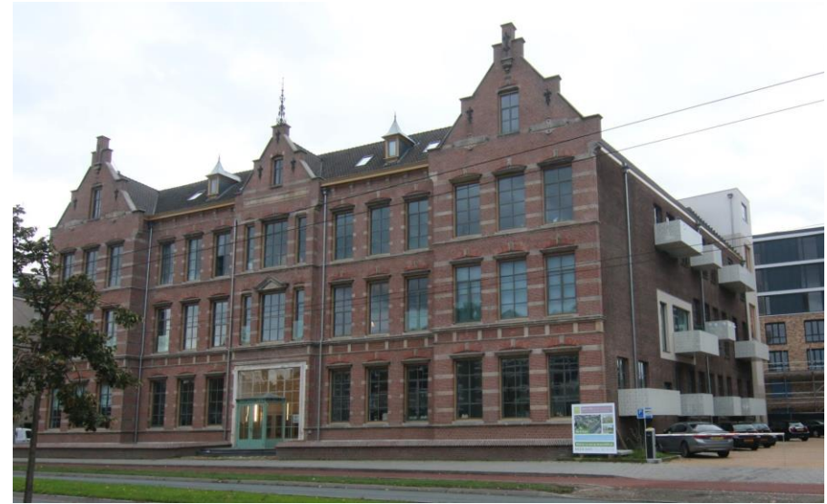
Ambachtsschool Arnhem tijdens verbouwing met balkons
