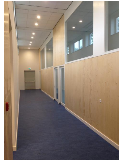
Nieuwe lokalen in gymzaal
