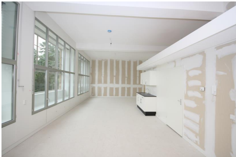
Overzicht met zicht op de breedte tussen de inbouw en isolatieschil
