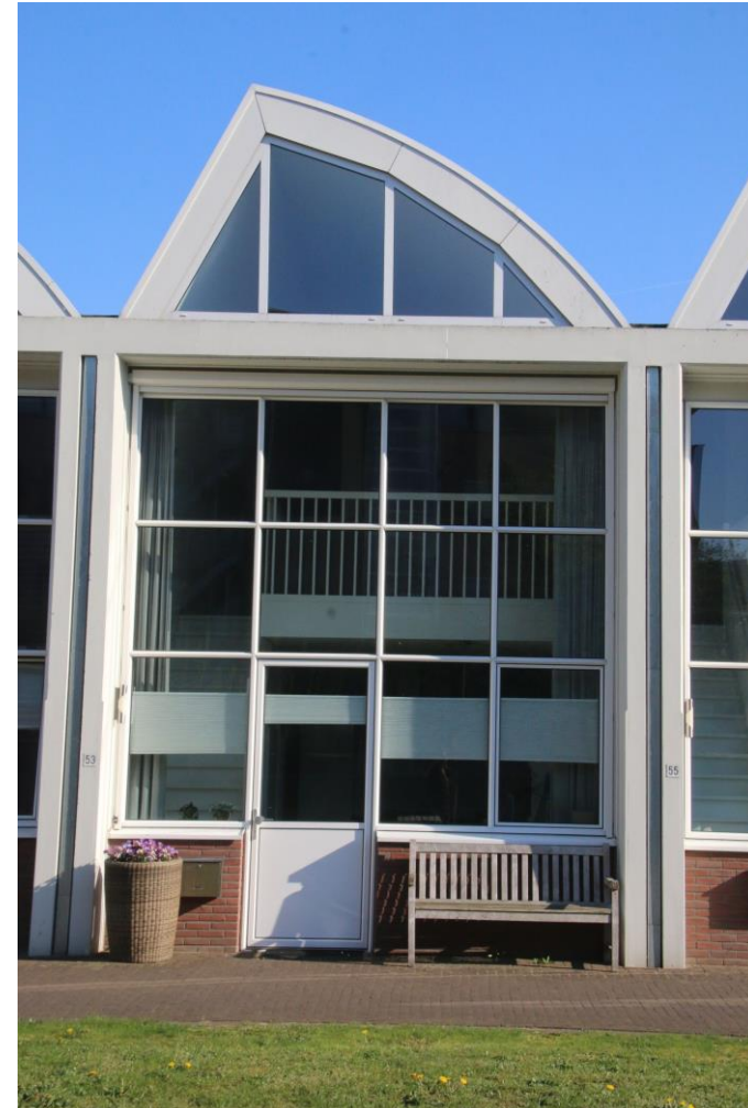
Een woning in onder een sheddak
