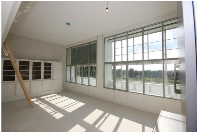
Overzicht 2 raams breed appartement in de Ambachtsschool
